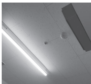
令和5年6月23日 2F機会庫2内スプリンクラー増設
